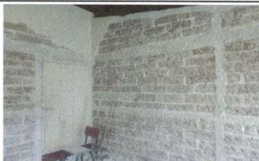
Foto 4: reparacion de repello y cernido de paredes modulo de aulas
