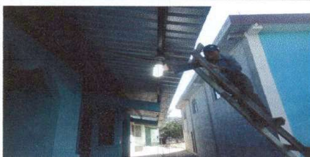
Foto 5: reparacion de lamparas
