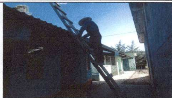
Foto 2: sustitucion de canales de metal modulo de aulas
