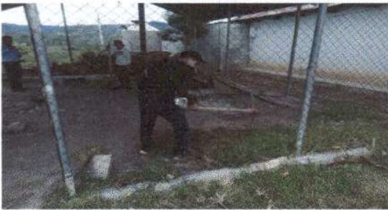
Foto 1: sustoticion de piso de torta de cemento
