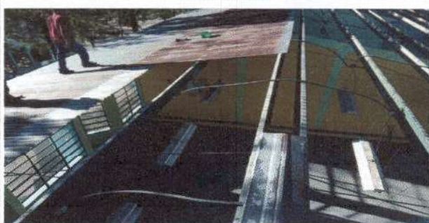
Foto1: sustitucion de lamina troquelada aluzinc calibre 26 modulo de aulas
