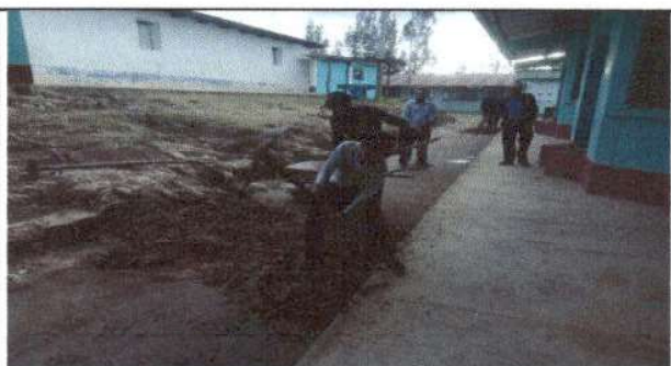
Foto 3: reparacion de planchas de concreto de patio
