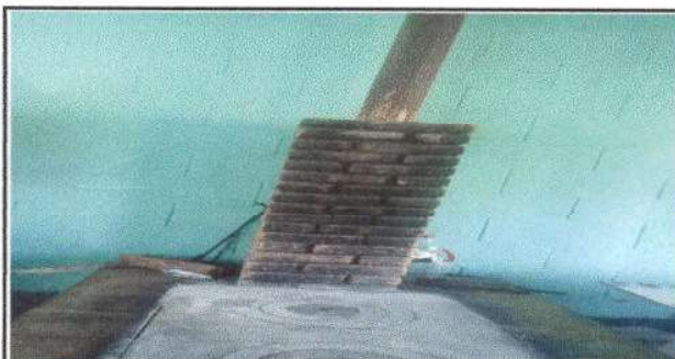
Foto 6: sustitucion de plancha de metal
